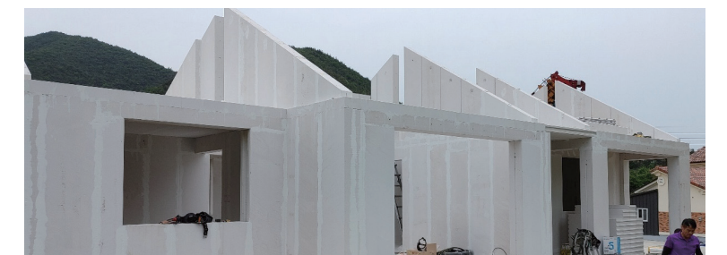
[사선패널 시공 사례]
