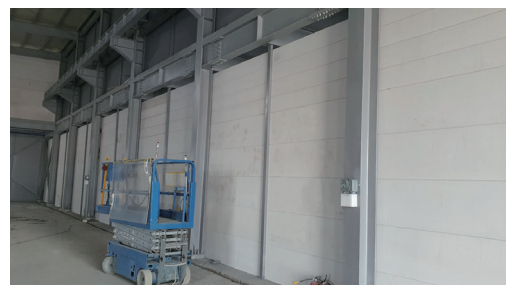
[벽패널 시공 사례]
