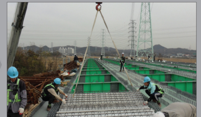
바닥판 타설 및 포장, 방호벽 시공
