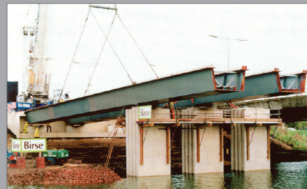
순차적 거더 가설 및 현장 이음 시행
