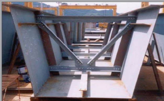
엄격한 품질관리하에 제작, 가조립, 검측 및 도장 시행
