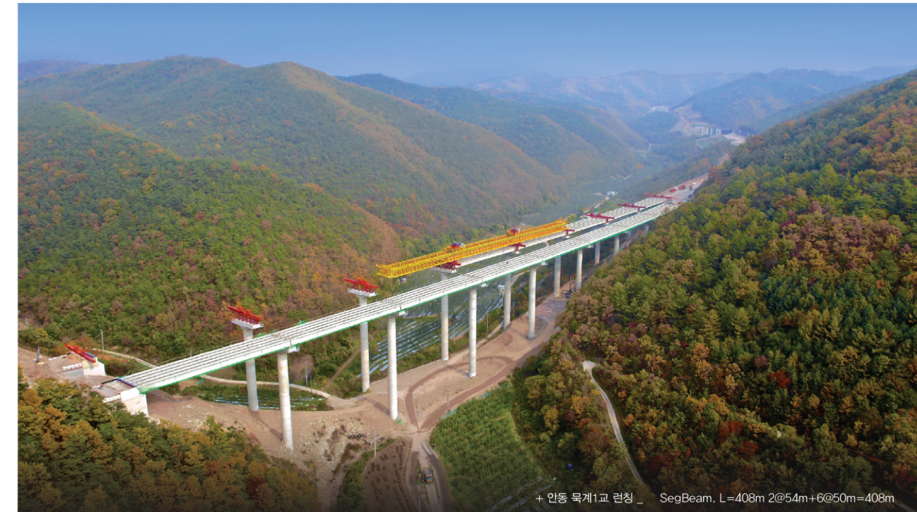
+ 안동 목계교 연철 _ SegBeam, L=408m 2@54m+6@50m=408m
